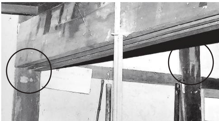
柱からずれた位置にある鴨居（左）と鴨居を差したほぞ穴の跡（右）
